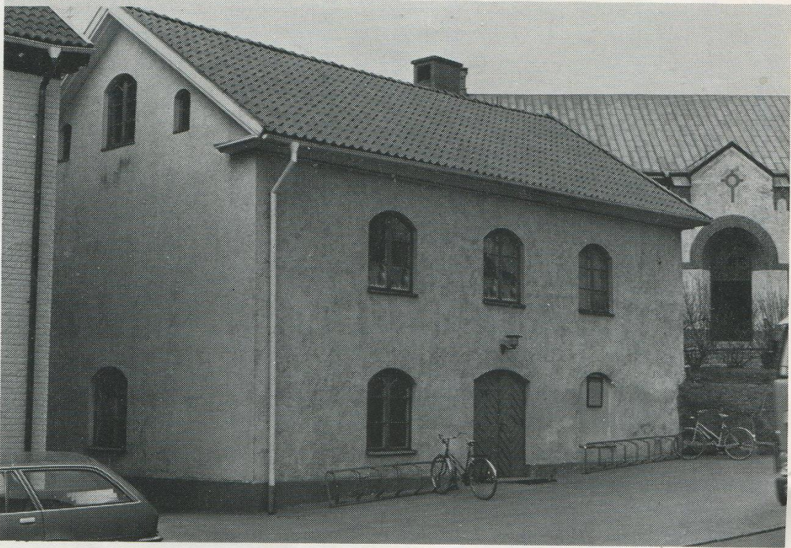
Bild 4. Sockenstugan, foto byggnadsinventeringen neg nr: 2:19—20. Sockenstugan. Troligen från slutet av 1700-talet. Ursprungligen byggd som samlingslokal för sockenstämman, fattigstuga och klockarbostad. Från mitten av 1800-talet har byggnaden använts för en rad olika ändamål: småskola, ölstuga, banklokal, brandstation och numera församlingslokal. Foto Östergötlands Läns Museum 1978
