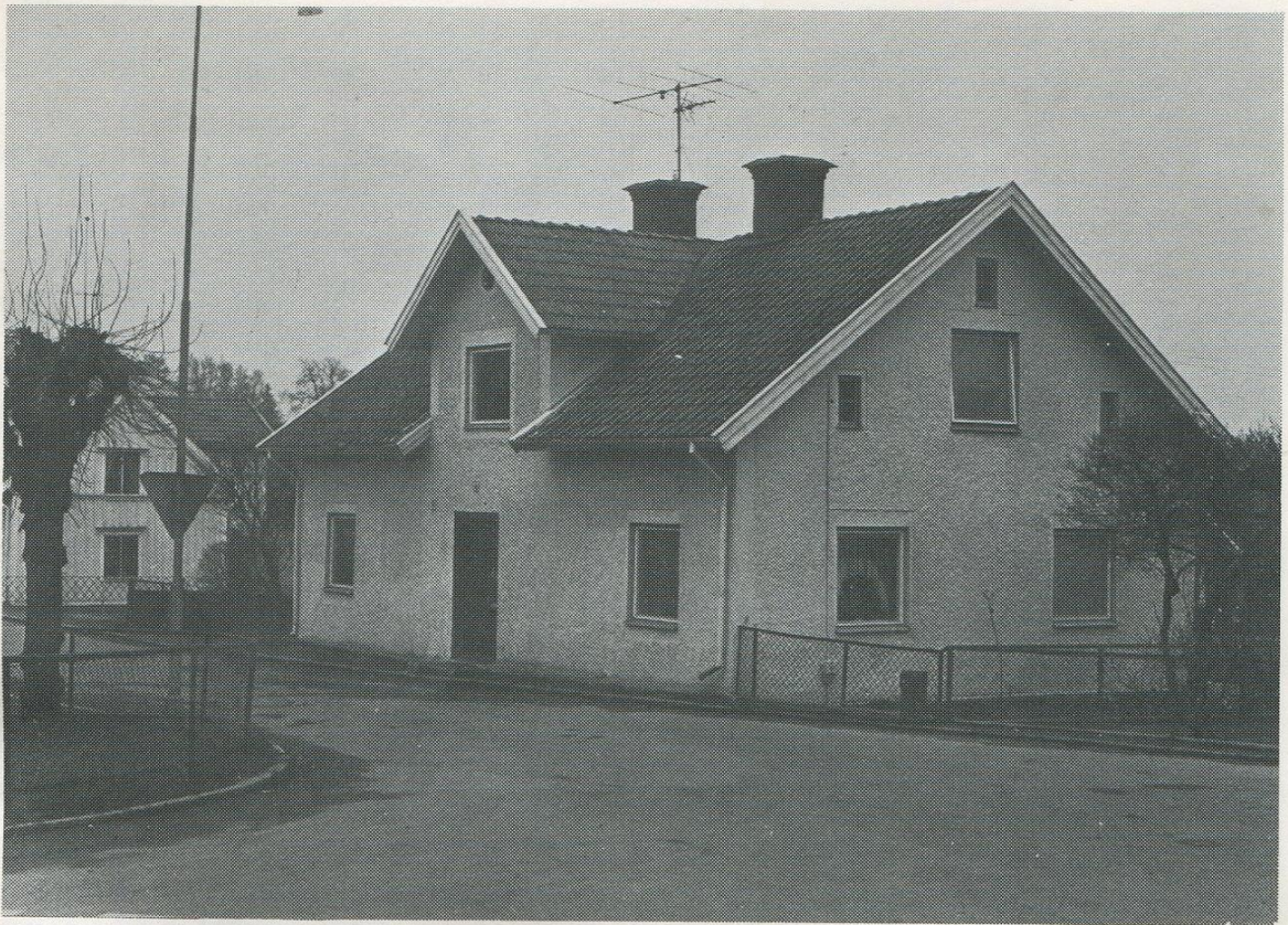
Bild 6. Byggnad vid Smedjegatan. Fastigheten Sanna 2 vid Smedjegatan uppfördes i slutet på 1870-talet av mejeristen August Andersson. Huset är byggt i samma stil som flertalet av byggnaderna längs Smedjegatan: Ett timrat envåningshus med inredd vindsvåning, frontespis mot gatan och reveterad eller panelklädd fasad. På 1880-talet bildade dessa hus en enhetlig rad längs gatan södra sida. I de nybyggda husen flyttade hantverkare och handelsmän in, som sålde sina varor och tjänster i salubodarna vid torget. Foto: Östergötlands Läns Museum 1978.
