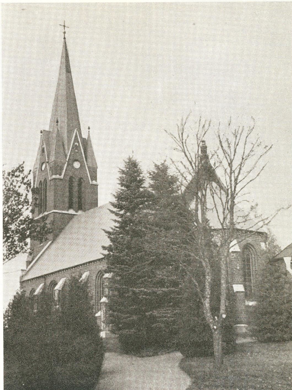
Boxholms AB uppförde 1897 Boxholms kyrka och skänkte den till församlingen. Materialet är unikt: slaggsten från Boxholms bruk. Till sin stil är kyrkan en typisk exponent för 1890-talets kyrkobyggnadskonst.
